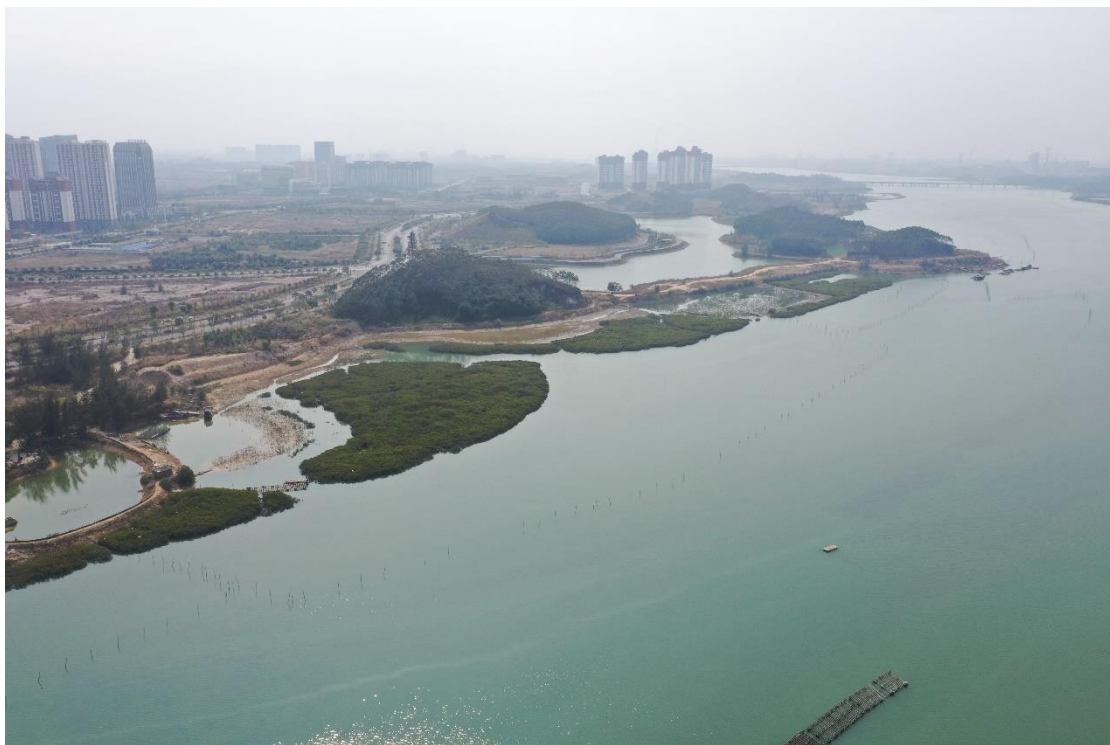
图 5.1.2-1b 本项目红树林宜林地种植施工围堰 4 现状（从东北向西南拍摄）
