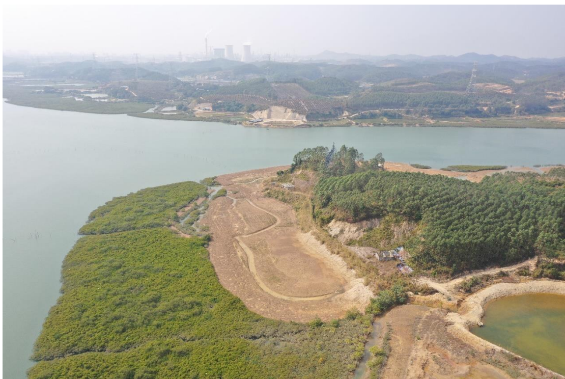
图 5.1.2-1c 本项目潮沟水系疏通工程现状（从东北向西南拍摄）
