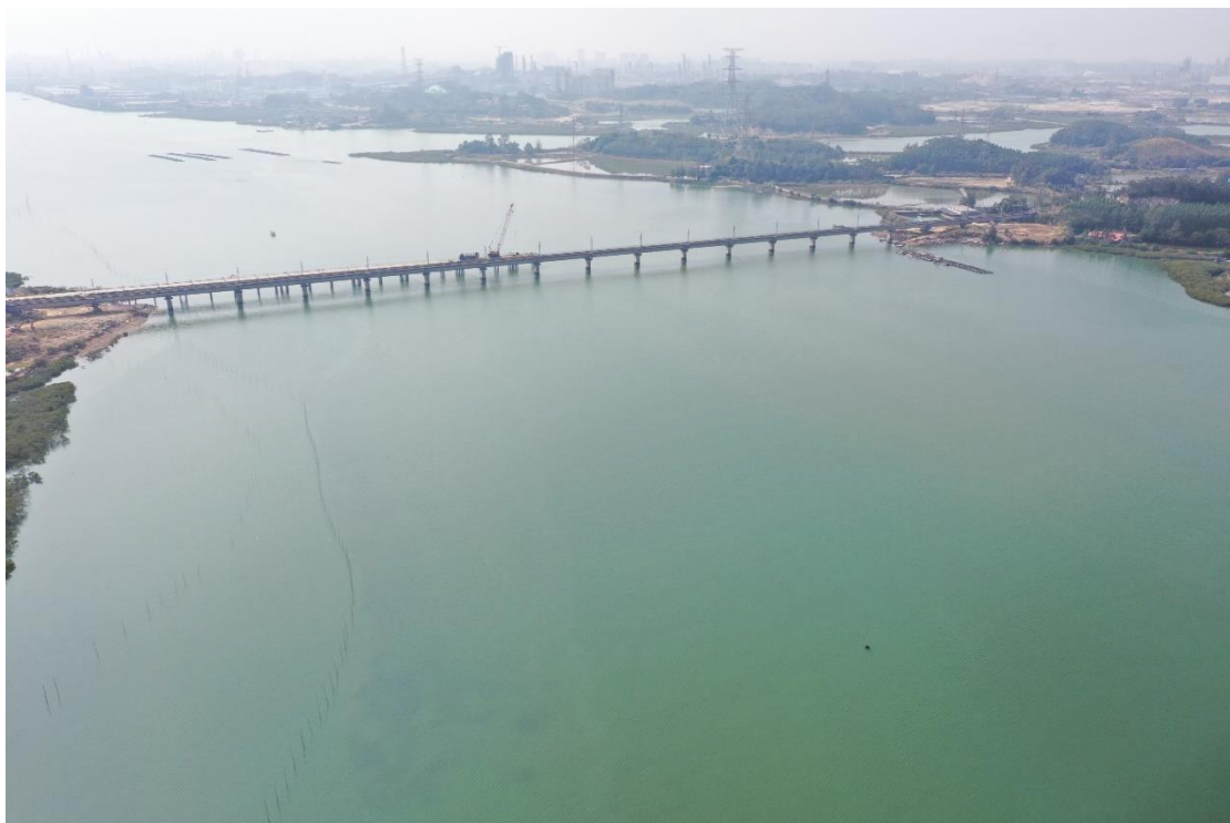
图 5.1.2-1f 金鼓江铁路大桥北侧用海区现状（从北向南拍摄）
